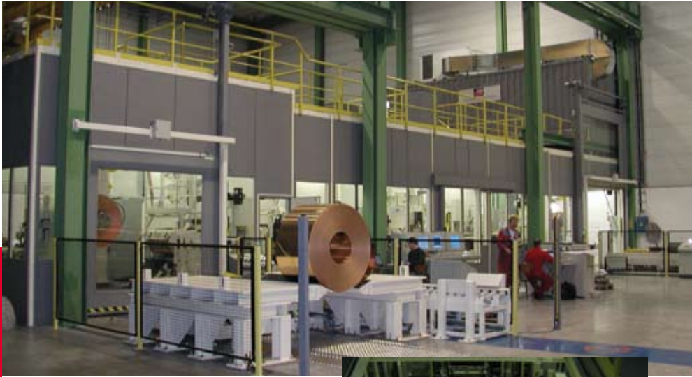
gekapselte automatische Anlage mit Schaltanlagen-Container encapsulated automatic line with switch-board container
