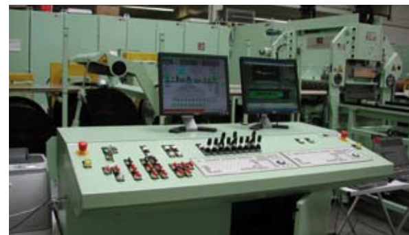
Hauptsteuerpult Main control desk
