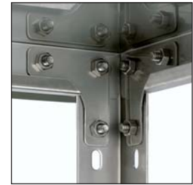
Gesamtstabilisierung durch Eckplatten.
