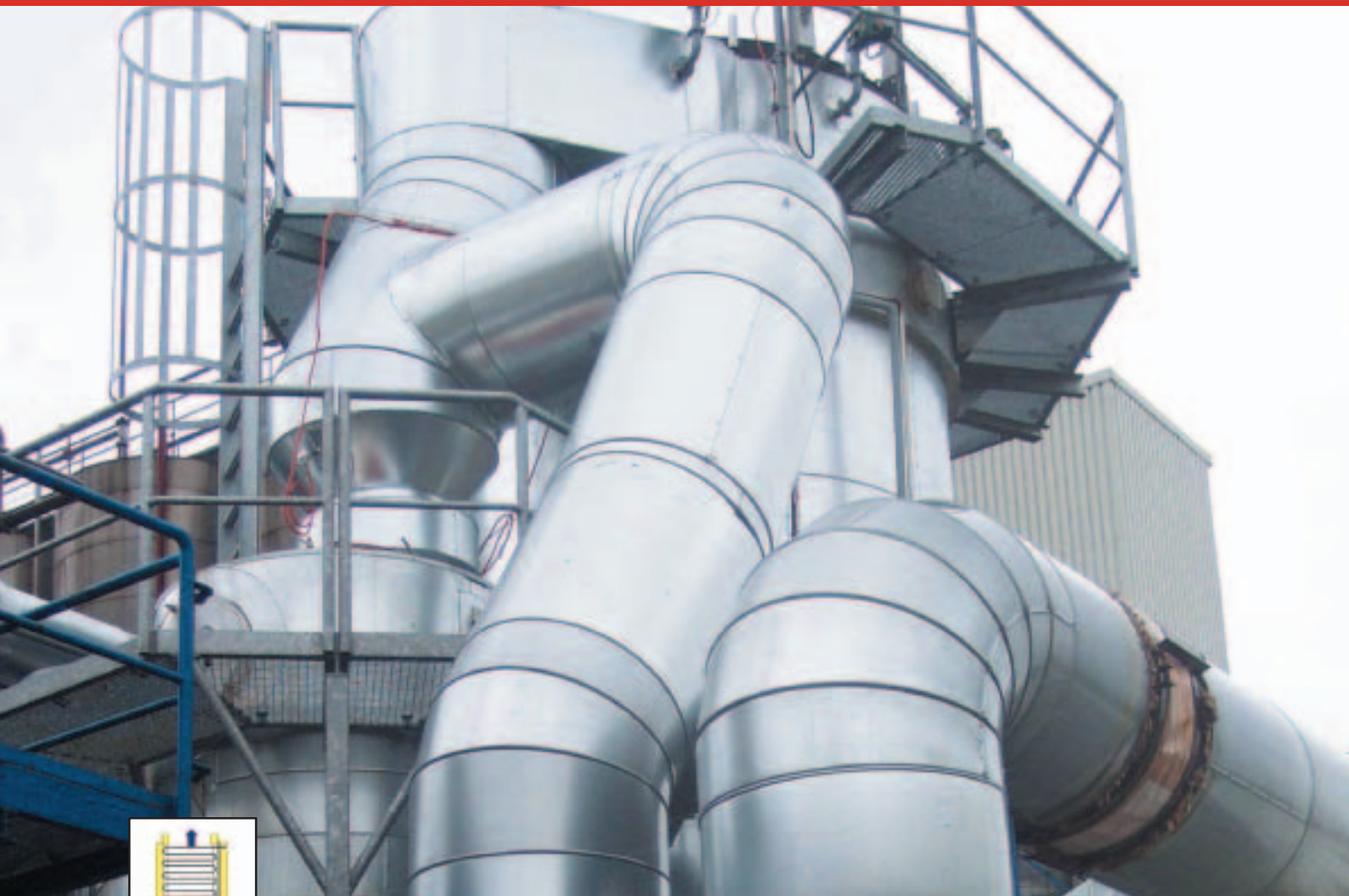
Система использования отработанного тепла после дуальной нейтрализации отработанного воздуха
